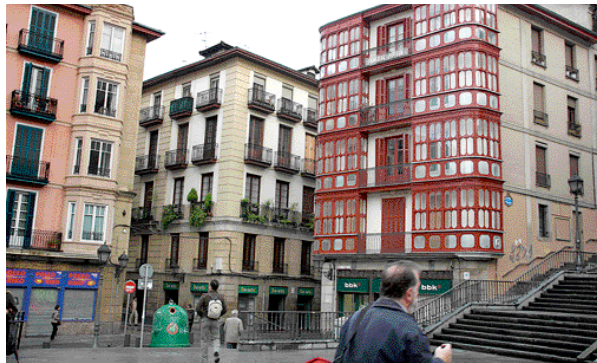
Los trabajos de mejora afectaron a un total de 122 edificios
